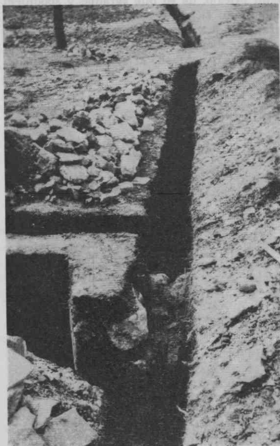
Zidovi pod zemljo. Ob kopanju jarkov za vodovodne cevi leta 1965 so odkrili spodnje dele srednjeveške zgradbe, in sicer pred špitalsko cerkvijo in na severni strani stoletne lipe.
