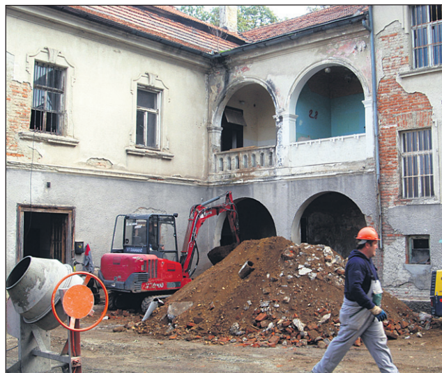
Delavci gradbenega podjetja GP Projekt ing te dni lovijo lepo jesensko vreme in na dvorcu Šterntal pospešeno opravljajo sanacijska in gradbena dela.
