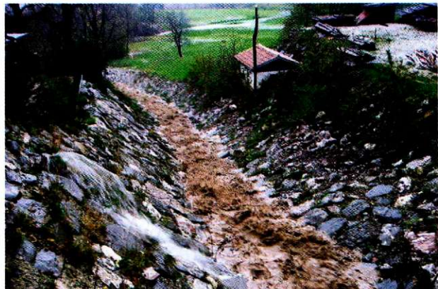
Ko se začnejo obsežnejše padavine, se potok Brusnik spremeni v blatno strugo, saj s plazu še vedno priteka velika količina t. i. murastega toka.
