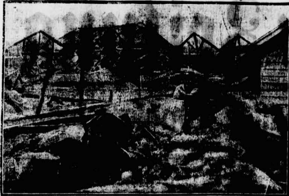
Zerstörte Wohnstätten überall.
