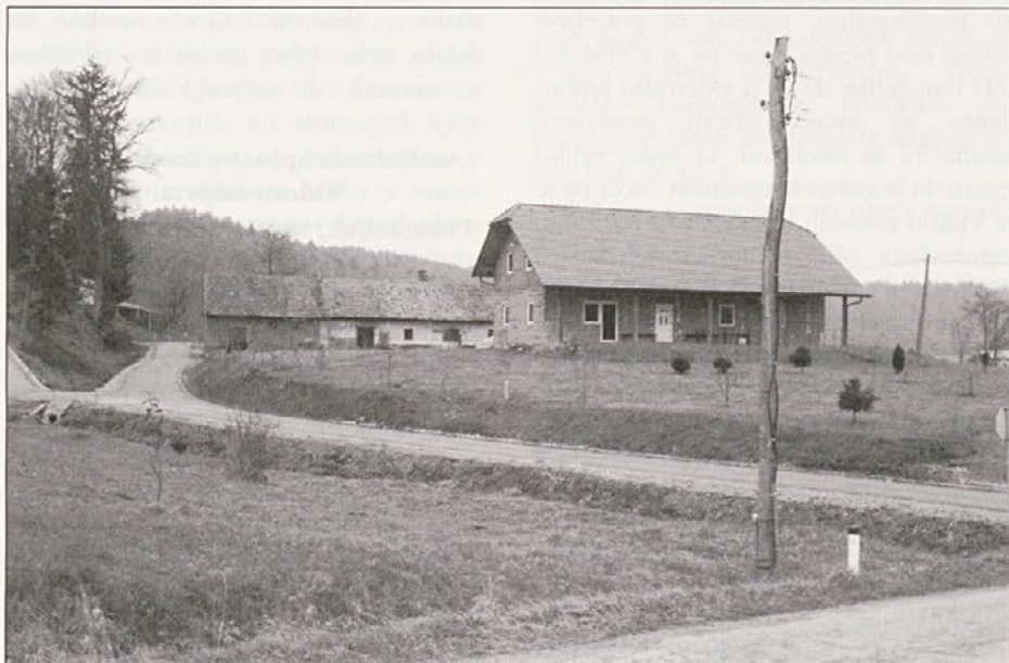
Novi asfaltirani odsek ceste v Zg. Pristavi
