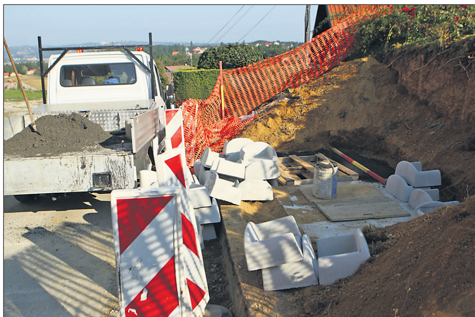
Gradnja prečrpališča v Kicarju, ki bo izboljšala oskrbo s pitno vodo le nekaj gospodinjstvom, bližnji begovi pa bodo na rešitev še morali čakati.
