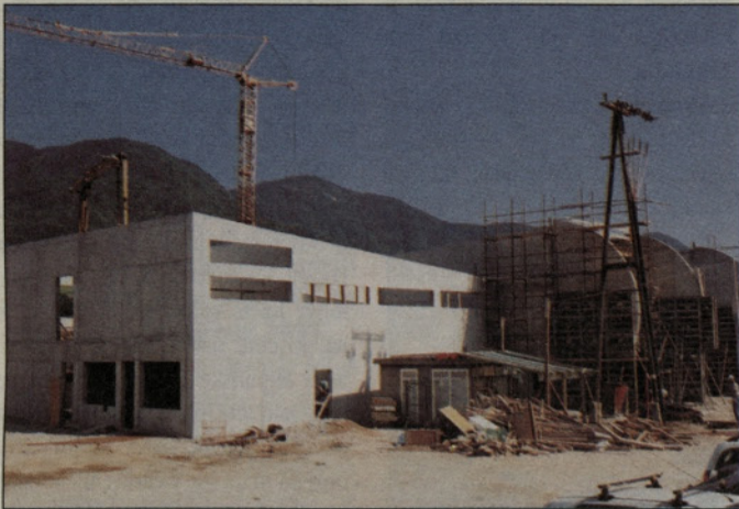
Kotlovnico gradi podjetje CMC Celje.
