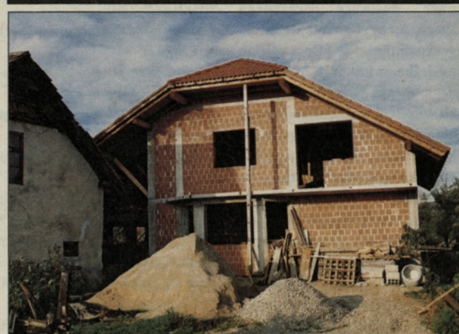
Gradnja nove hiše poteka počasi.
