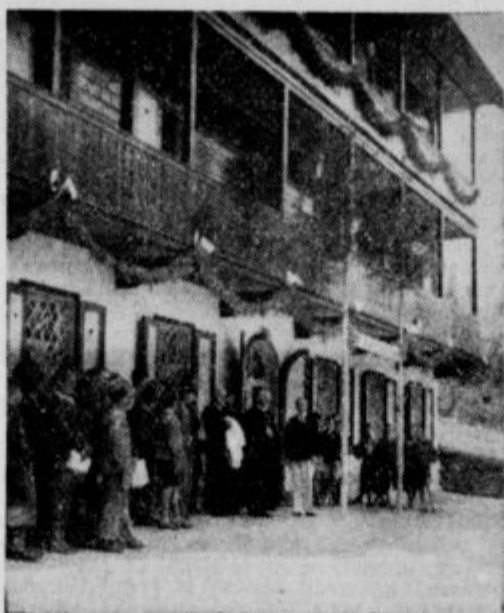
Pogled na pročelje doma, ki je bil lepo okrašen.
