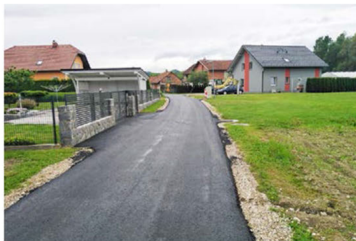
Odsek ceste Lah–Jeromel je že moderniziran.
