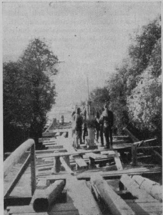
Gradnja mostu čez Krko (julij 1919)
