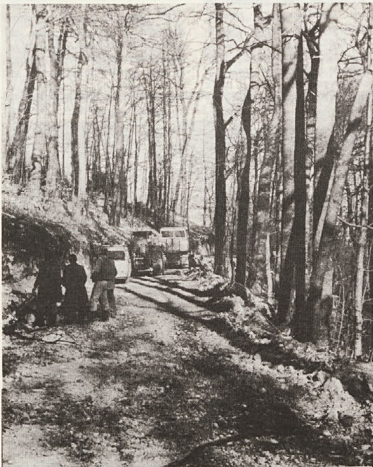
Gradnja ceste Črno lice – Krči. Januar je bil brez snega, mraz pa strupen. Nad Pendirjevko brije hladna burja, zato si delavci radi pogrejejo premrle roke. (Foto M. Bajt)
