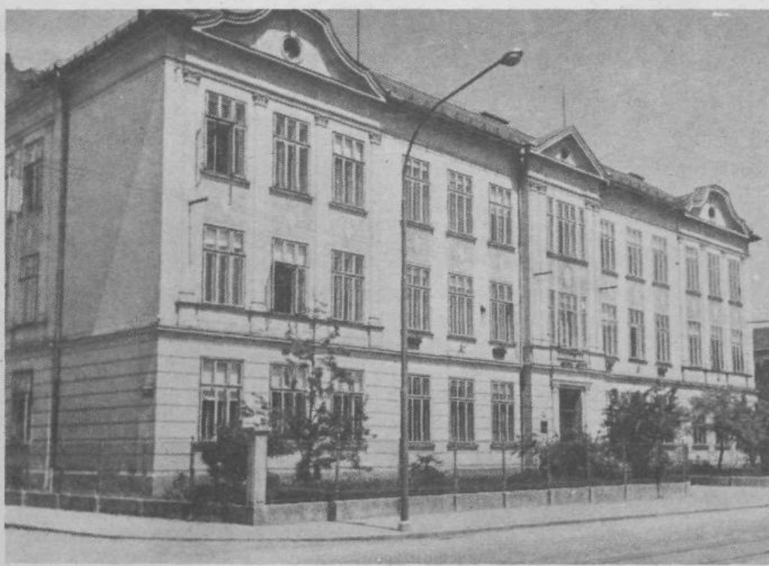
Poslopje VI. gimnazije Moste je zidano pred dobrimi šestdesetimi leti. V stari stavbi ob hrupni Zaloški cesti, je pouk dijakov dokaj težaven
