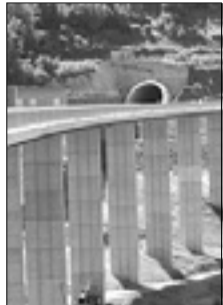
GRADBIŠČE HITRE CESTE BUMBACA
