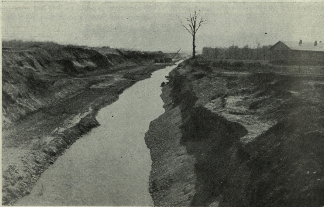
Sl. 4. Odvodni kanal
