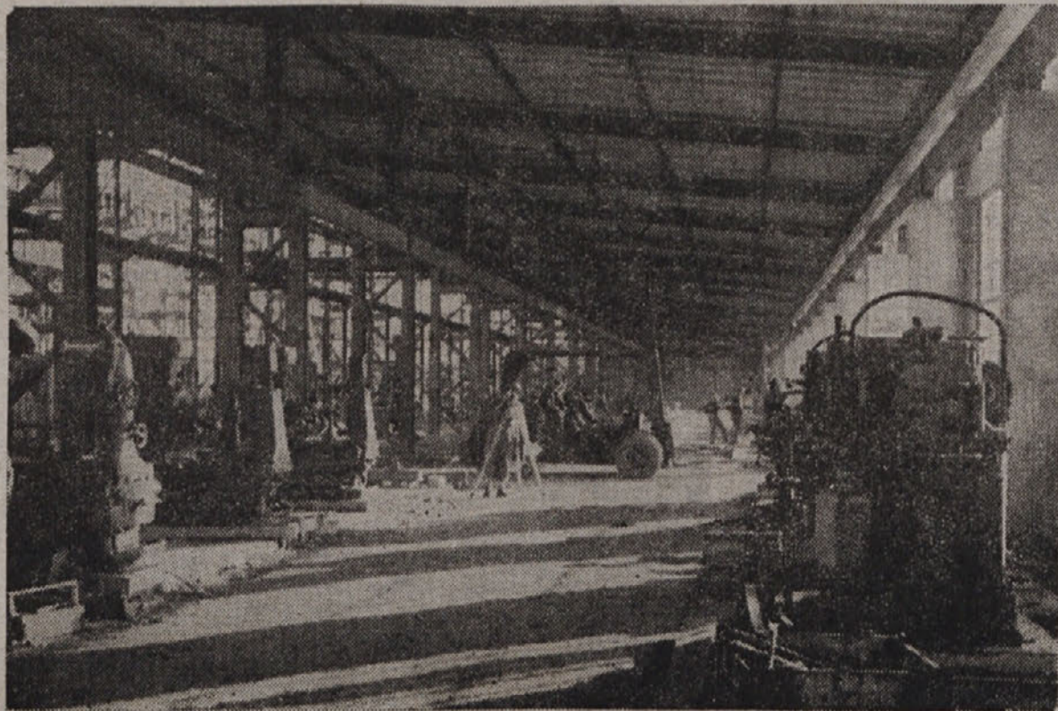
POSTAVLJANJE STROJEV V TOVARNI V ŽELEZNIKU PRI BEOGRADU
