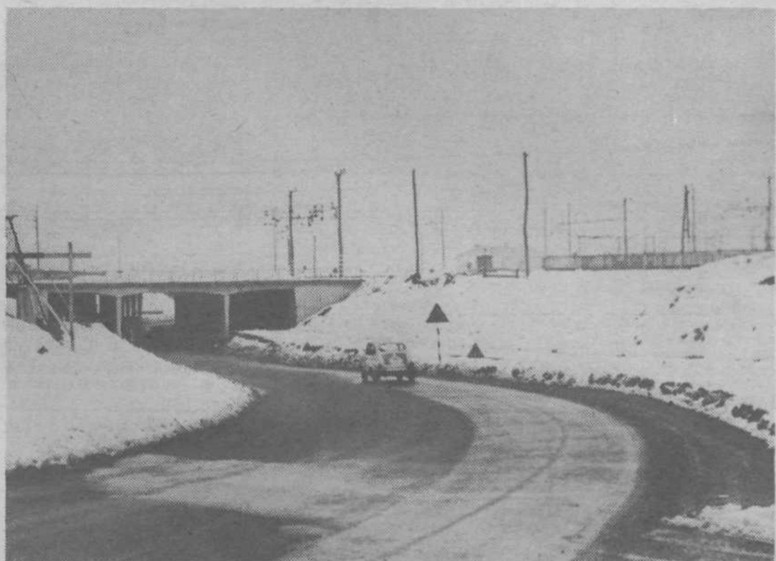
Toliko pričakovani podvoz v Zalogu je končno nared. Odslej ne bo treba več izgubljati dragocenega časa in živcev ob zapornicah.
