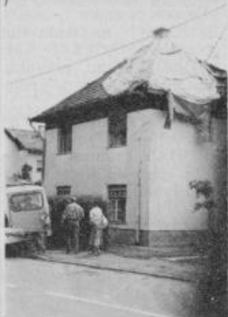
Na Grandučevo hišo je padel del ostrešja Čavičeve hiše.
