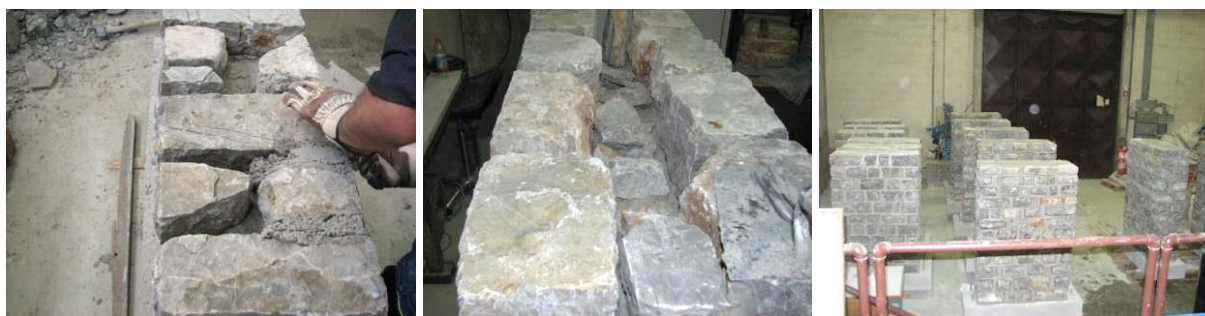
Slika 8.2: Gradnja zidov z vezniško zvezo (levo), s smerniško zvezo (na sredini) ter preizkušanci pred izdelavo zgornjih betonskih blokov (desno)
