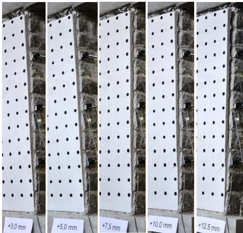
Figure 3.72: Increasing of the plaster's detachment with increasing amplitude displacements at test 8 - SNv-15-1 Slika 3.72: Povečevanje odstopanja ometa s povečevanjem amplitud pomikov pri testu 8 - SNv-15-1
