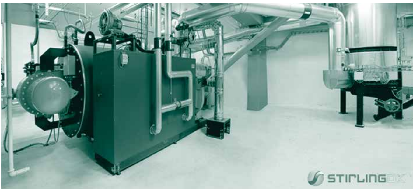
Slika 2: Sistem kogeneracije na lesno biomaso s Stirlingovim motorjem (Vir: www.stirling.dk ).
