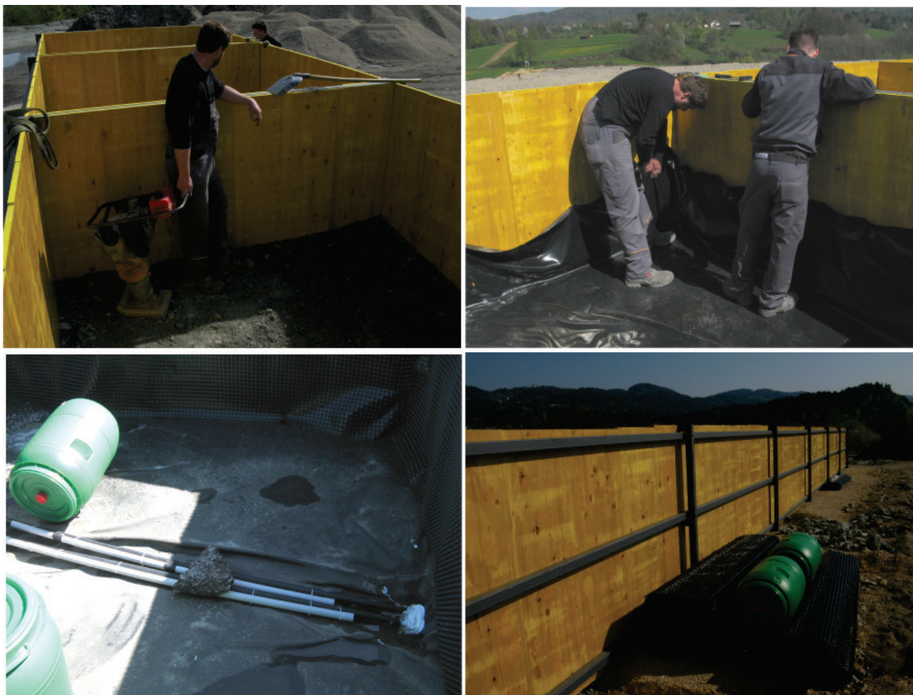
Sl. 3. Priprava vodo neprepustne podlage, oblikovanje odtočnega kanala in montaža drenažnih cevi. Fig. 3. Preparation of a waterproof base layer, design of a drainage channel and installation of drainage pipes.
