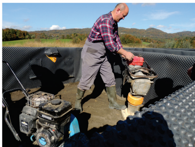
Sl. 4. Mešanje kompozita in njegova vgradnja v lizimetre, zgoščevanje z nabijalcem in vibracijsko ploščo.
