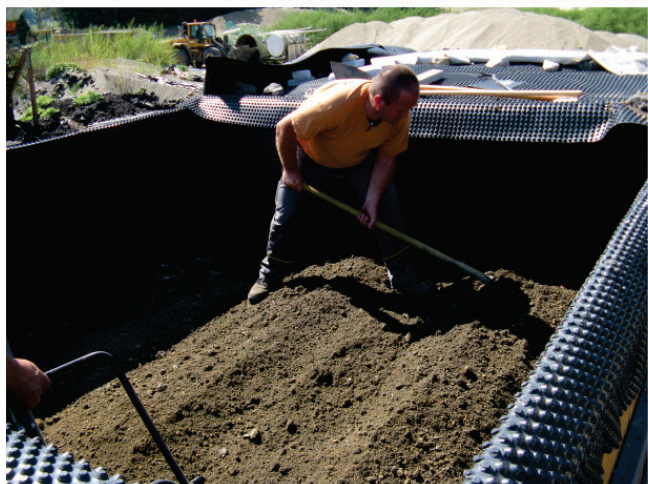
Sl. 4. Mešanje kompozita in njegova vgradnja v lizimetre, zgoščevanje z nabijalcem in vibracijsko ploščo.
