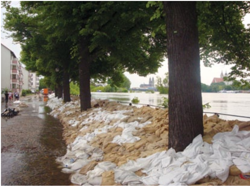
Slika 2: Protipoplavni nasip iz vreč peska na desnem bregu Labe v Magdeburgu 9. junija 2013 (foto: Jure Natek).
