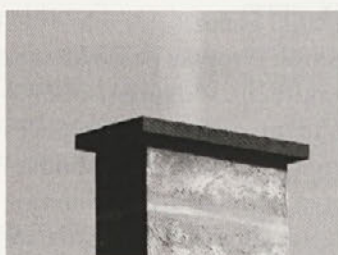
Svetel – neviden dim, razen pare, je pokazatelj dobrega zgorevanja, za strokovno presojo so sicer potrebne meritve emisij.
