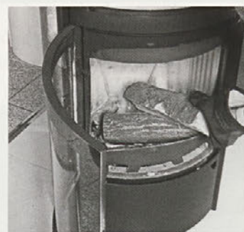
Pri ponovni naložitvi praviloma dodamo eno ali dve poleni na žerjavico. (Vir: www.heimwerkerlexikon.selbermachen.de )
