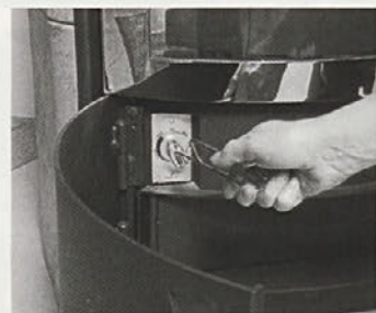
Toplotna moč se določi s količino dodanih polen, le izjemoma z regulacijo zraka. (Vir: www.heimwerkerlexikon.selbermachen.de )
