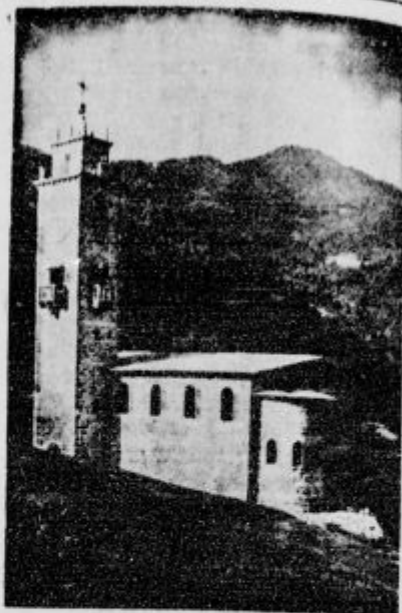
V Gornji Rečici nad Laškim so v pretečenih dneh dokončali zidarska dela pri novi cerkvi sv. Antona. Cerkev je 18 m dolga, 11 m široka in 9 m visoka. Zvonik ima do krita 26 m višine.
