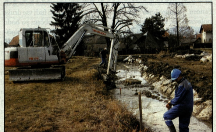
Dela že potekajo
