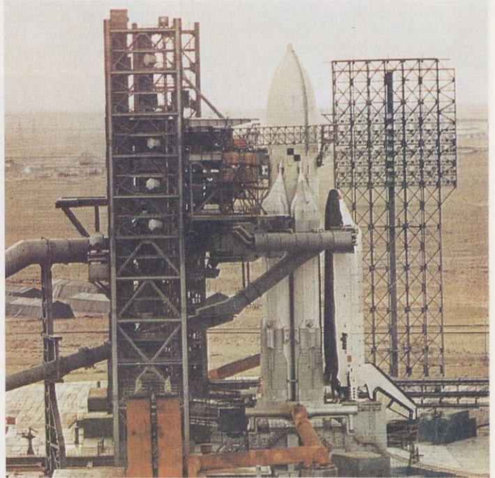
Energija z Buranom na drugi (redni ali običajni) izstrelitveni rampi. Zgornja cev je namenjena pribodu dvigala s kozmonavti, spodnja cev pa nudi možnost hitrega zdrsa vesoljcev in osebja po več žlebovih do ločnih bunkerjev (vseh bunkerjev je 16) z bliskovitim zapiranjem jeklenega pokrova. Z bunkerji je povezana tudi zgornja cev.
