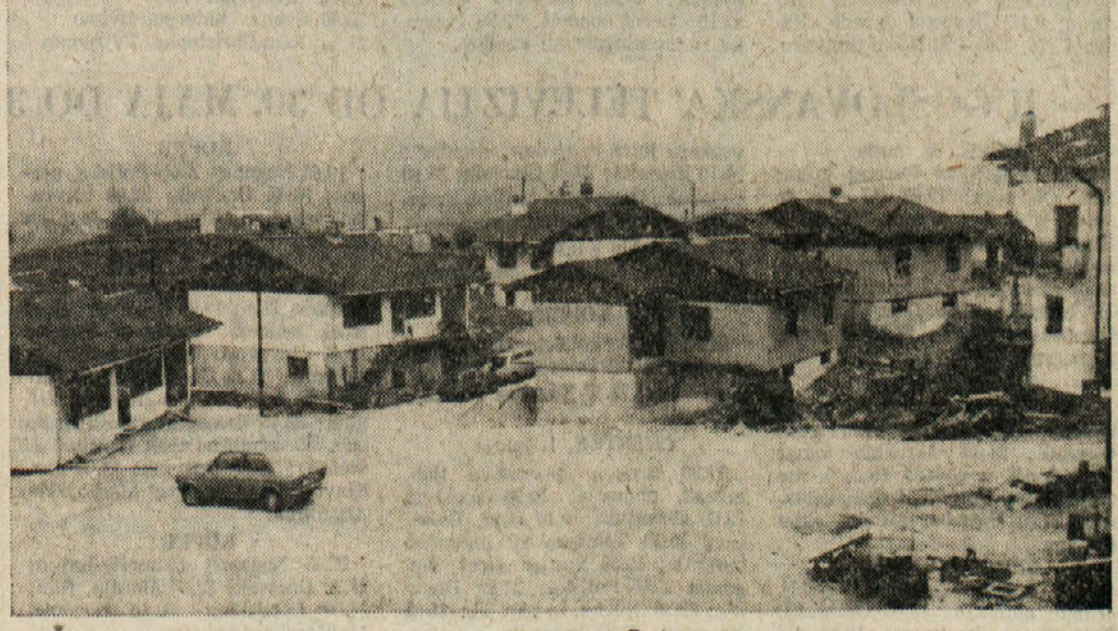
Novo lične in čvrste betonsko - montažne hiše SGP iz Nove Gorice v Bardu tik pred izročitvijo novim stanovanjem. Večerja so izročili 6 takih hiš
