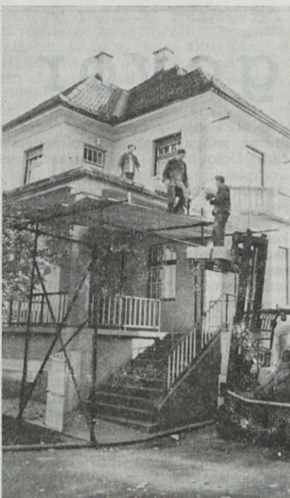
Pričetek gradnje novega pisarniškega prostora.
