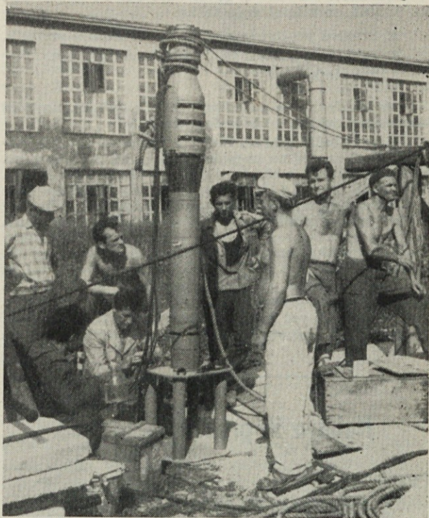
Sondiranje terena za vodovod
