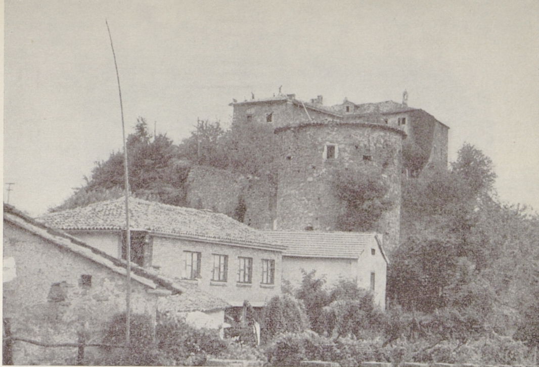
Premški grad med obnovo
