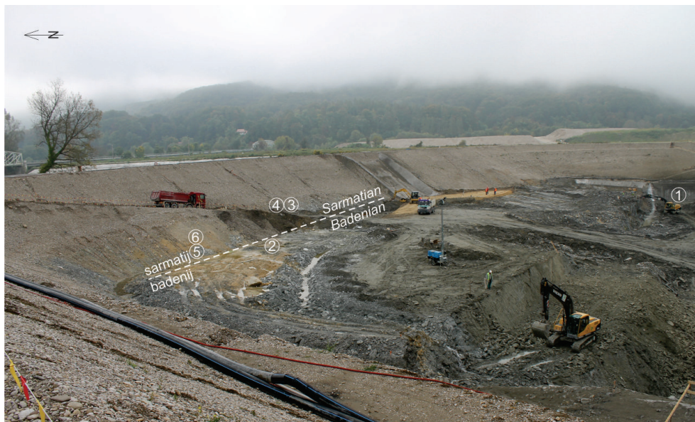
Sl. 2. Gradbena jama za hidroelektrarno Brežice v letu 2014.
