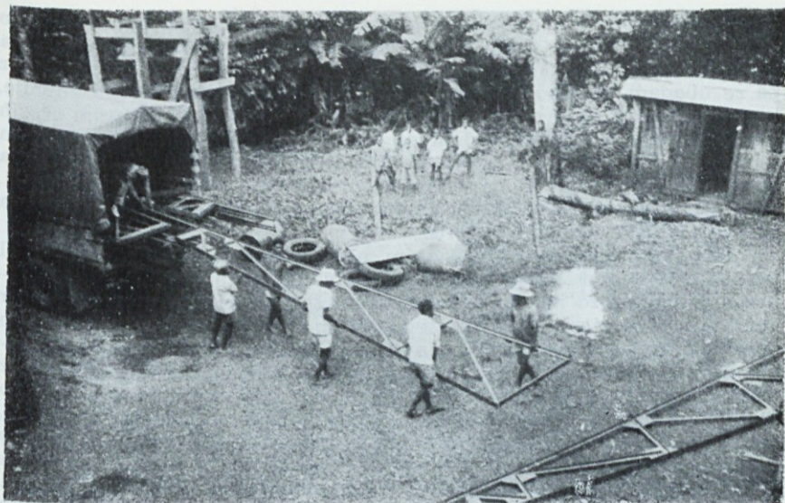
Za novo cerkev sv. Jožefa v Vangaindrano so že napravili in pripeljali strešno ogrodje, ki ga zdaj razkladajo s tovornjaka.
