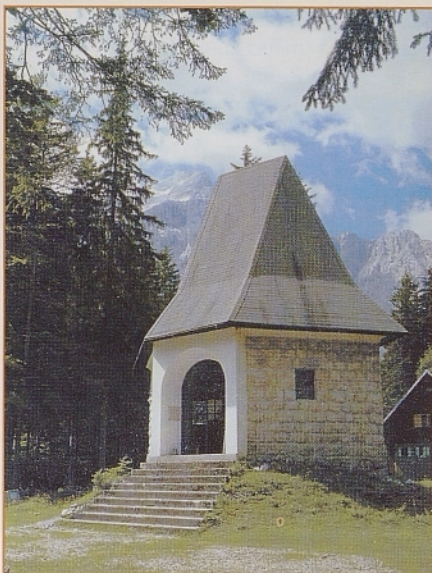
Aljaževa kapela, posvečena sv. Cirilu in Metodu, zgrajena v Vratih pod Triglavom l. 1928 po načrtih arh. Ivana Vurnika (foto C. Velkovrh).
