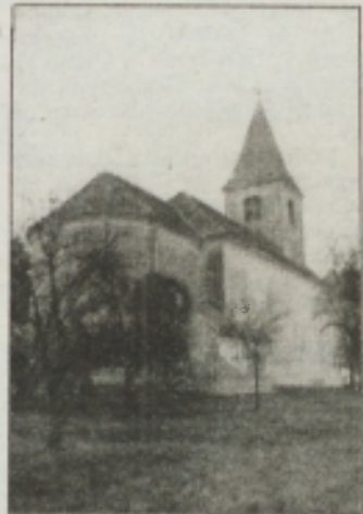
Župnijska cerkev sv. Štefana Hardinga v Števanovcih je mogoča stavba izpred več kot 210 let. Medtem ko notranost še kljubuje času, zunanost klife po novem pročelju, izolaciji sten. – Fotografija: Š. S.
