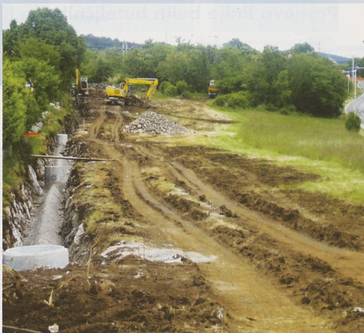
Del kanalizacije do črpališča
