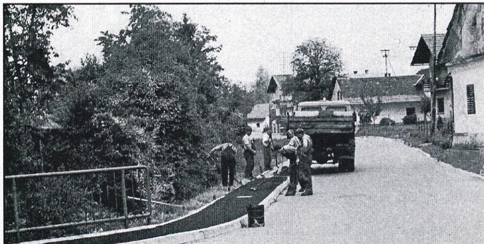
2. Prvi in edini pločnik v vasi je dobil asfaltno prevleko. Na tem najnevarnejšem odseku ob Pšati bodo otroci na poti v šolo in iz nje veliko manj izpostavljeni avtomobilom.
