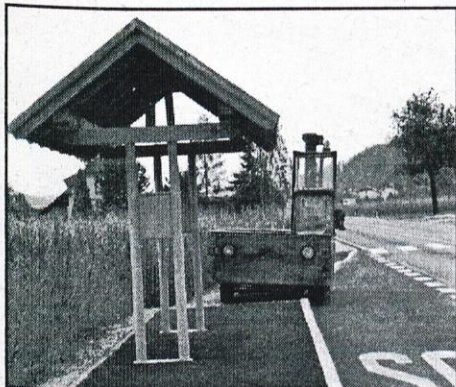
1. Avtobusni postaji v Loki - na fotografiji še med zaključnimi deli - sta dobili dokončno podobo. Potniki so zdaj pod streho, lahko se usedejo, vsekakor pa varneje čakajo na svoj prevoz. Upamo, da bodo kmalu postavljeni prometni znaki in semafor.
