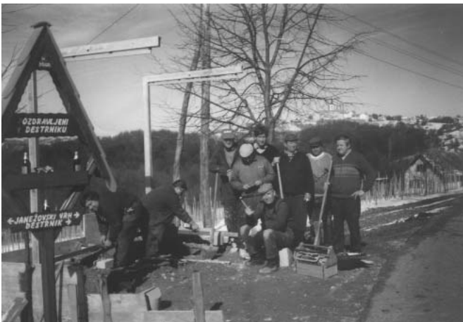
Vaščani pri postavitvi avtobusnega postajališča
