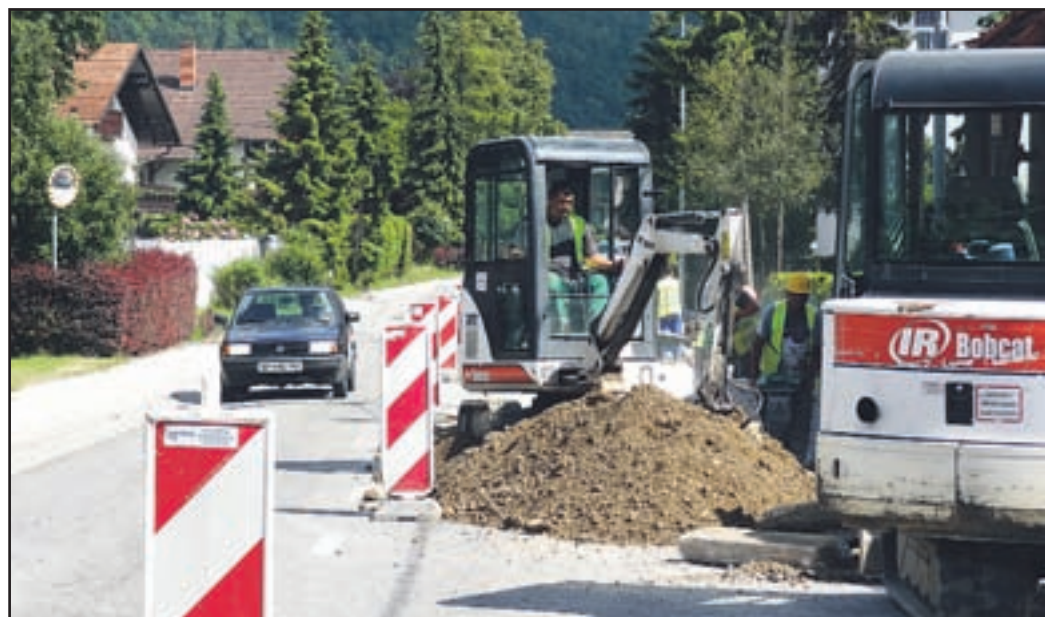
V občini Šmartno ob Paki je največje gradbišče prav v središču kraja.
