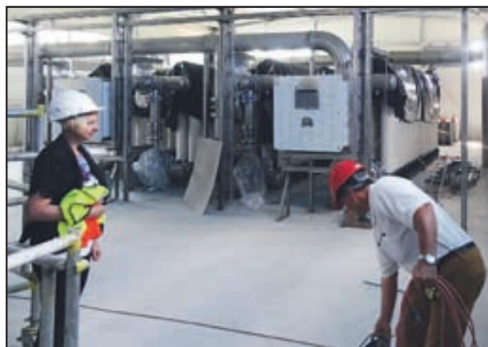
Obnova in razširitev naprave za pripravo pitne vode na Grmovem vrhu je v polnem zamahu.
