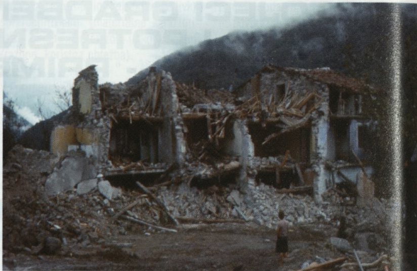
Slika 1: Posočje, 1976: porušitev stare, tradicionalno sezidane kamnite hiše
