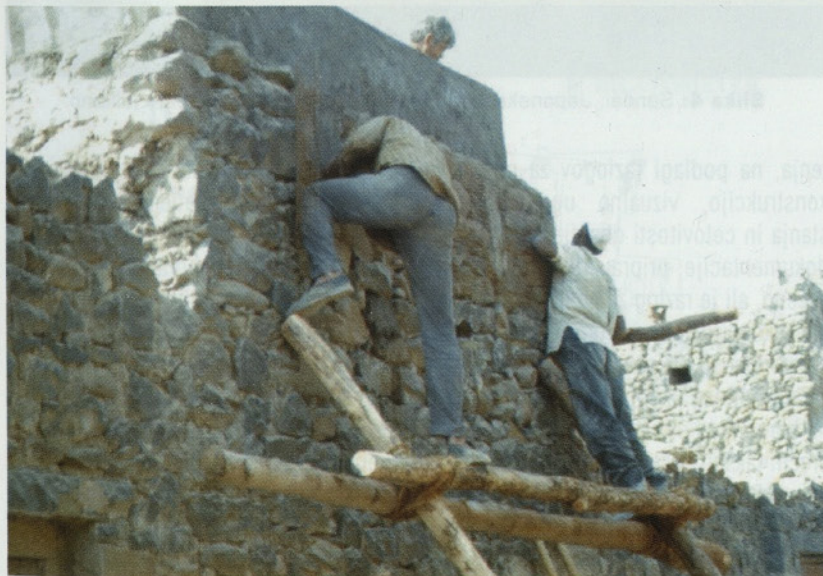
Slika 3: Killari, Indija: utrjevanje tradicionalno grajene hiše z lokalno tehnologijo in delovno silo
