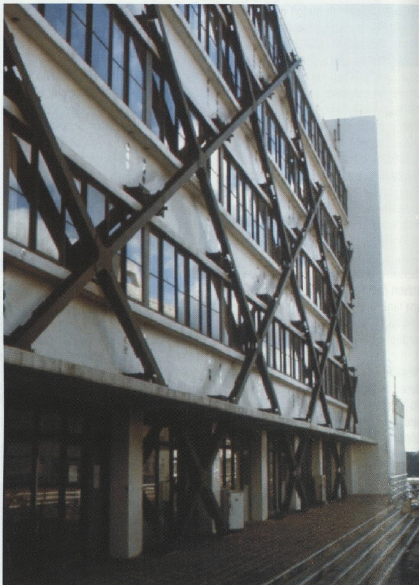
Slika 4: Sendai, Japonska: utrditev šolske stavbe z zunanjo jekleno konstrukcijo
