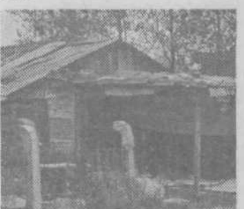
Pred nedavnim so »padle« barake ob Tovarniški ulici — foto TOM
