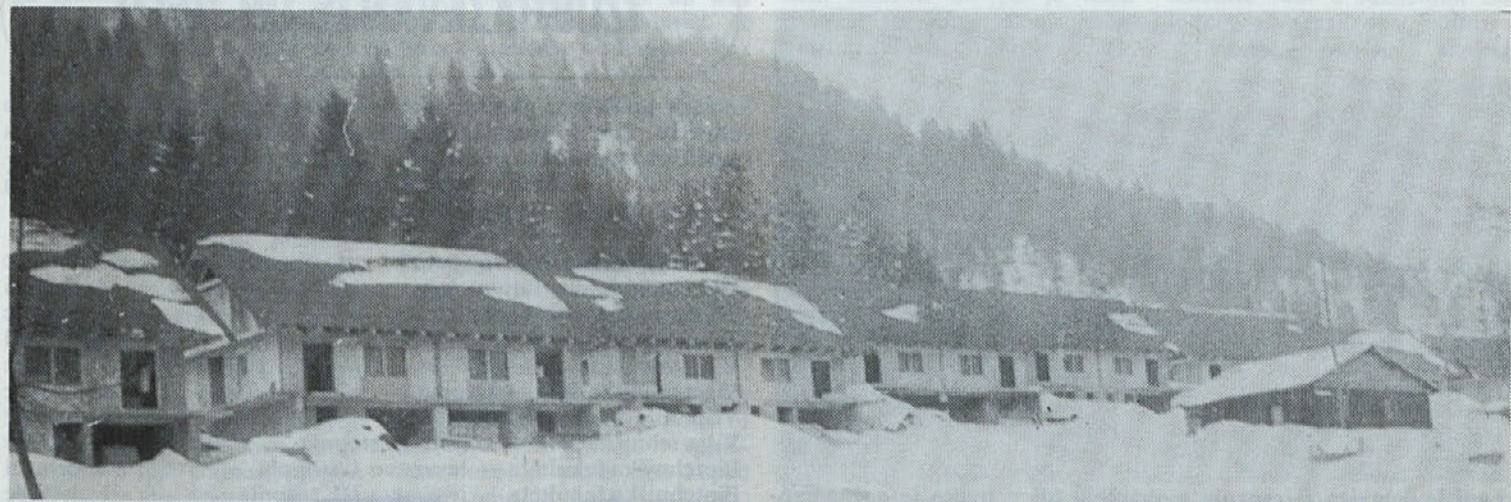
Čeprav je bila letos zima izredno dolga, pa so na Hrušici pri Jesenicah vseeno gradili novo naselje montažnih hiš Jelovica. Čeprav še nima končnega izgleda, bo nedvomno izredno lepo in kot tako zagotovo lahko ponos delavcev Jelovice.
