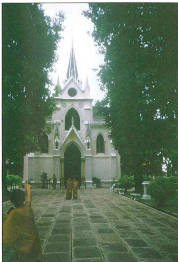
Wat Nivet Dhamma Prawat (1877-1879). Veduta della facciata. (Foto: L. Nalesini, 1998).
