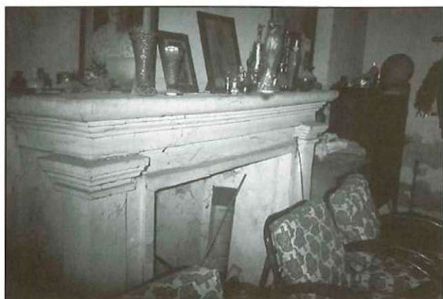
La prima casa costruita dal Grassi a Bangkok (prima del 1875). Caminetto ornamentale. (Foto: L. Nalesini, 1998).
