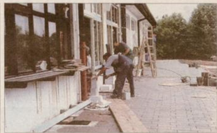
Obnove spremljevalnega objekta so se lotili nazadnje
