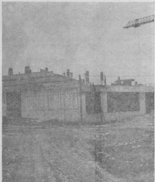
Delavci SGP Stavbenik Koper, tozđ Gradbeno operativa Ljubljana, gradijo v Medvodah na Svetju osnovno šolo s 14 učilnicami in večnamenskim prostorom. Objekt II. samoprispevka ljubljanskih občanov bodo predali namenu septembra prihodnje leto. (Foto: F. Rozman)
