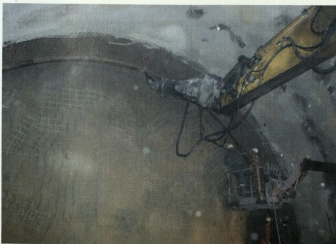
Slika 5 • Nameščanje jeklenega loka K24
