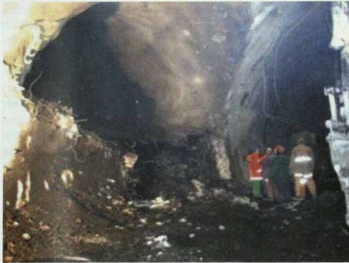
Slika 10 • Pričetek izkopa povoznega prečnika
