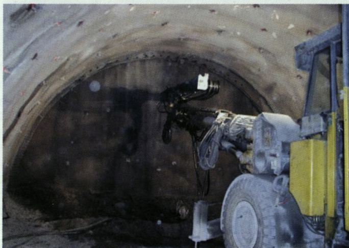
Slika 8 • Vgradnja IBO sider v kamninski steber pred izkopskim čelom
