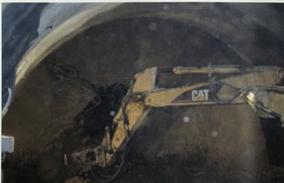
Slika 16 • Fazni izkop v kaloti v hribinski kategoriji SCC2
