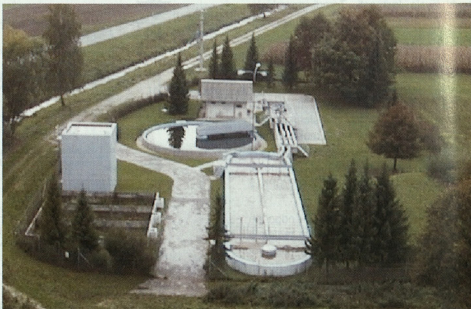
Slika 10 • Kontinuirna čistilna naprava za komunalne odpadne vode v Dobrni s simultano nitrifikacijo in denitrifikacijo (1983)
