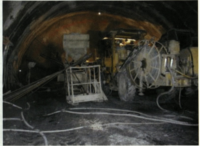
Slika 11 • Priprava na vgradnjo jeklenega cevnega štita
