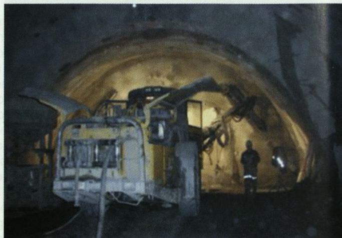
Slika 9 • Vgradnja mikropilotov v desni bok predorske cevi
