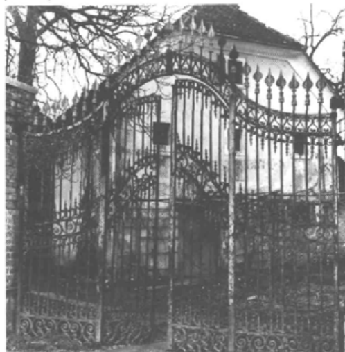
34. V opečnat zid, postavljen leta 1917, so Lenarčičevi vgradili umetelno oblikovana kovana železna vrata z dvojnimi odpiranjem, pobarvana v črno-zlato-srebrni barvni kombinaciji
