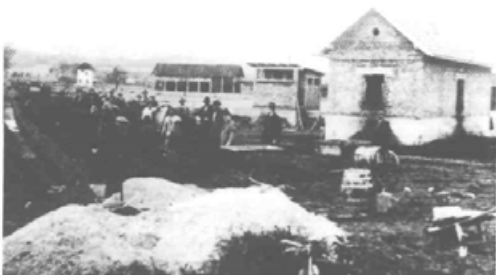
67. Fotografija gradnje postaje Vrhnika trg.
