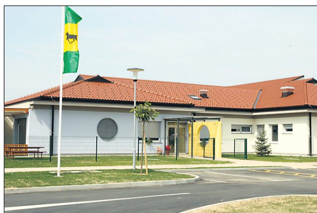
Novozgrajen vrtec v Križevcih
