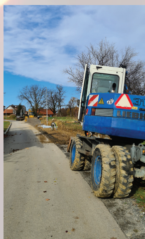
Kolesarske poti se že gradijo
