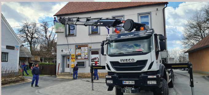
Elektriko so položili v zemljo
