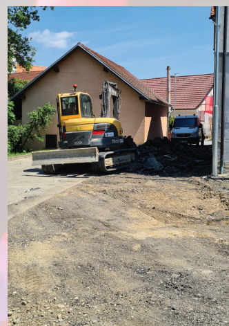
Gradbena dela ob ureditvi ceste
