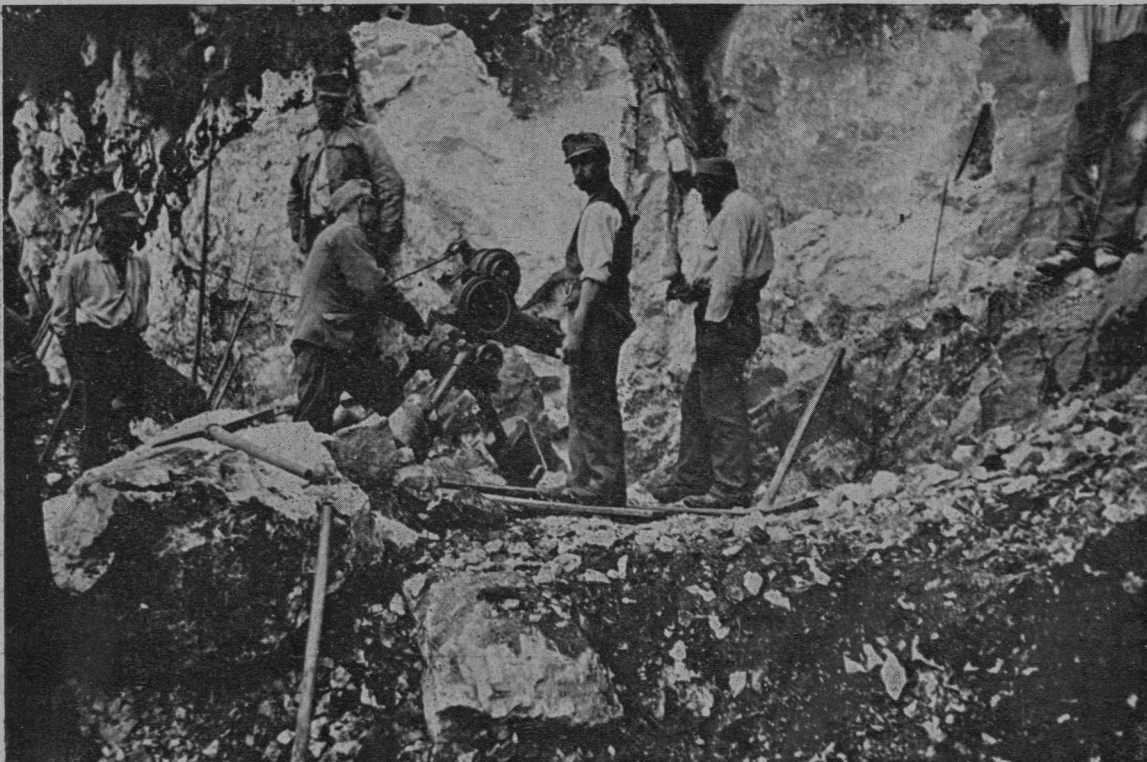
Električni vrtalni stroj pri stavbi žične zračne proge v tirolskih Alpah.
