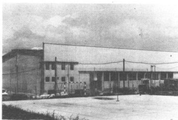
Novo proizvodne prostore, ki merijo 1.000 kvadratnih metrov in bodo veljali 55 milijonov dinarjev, bodo predvidoma odprli ob občinskem prazniku, namenjeni pa bodo proizvodnji hidravlike
