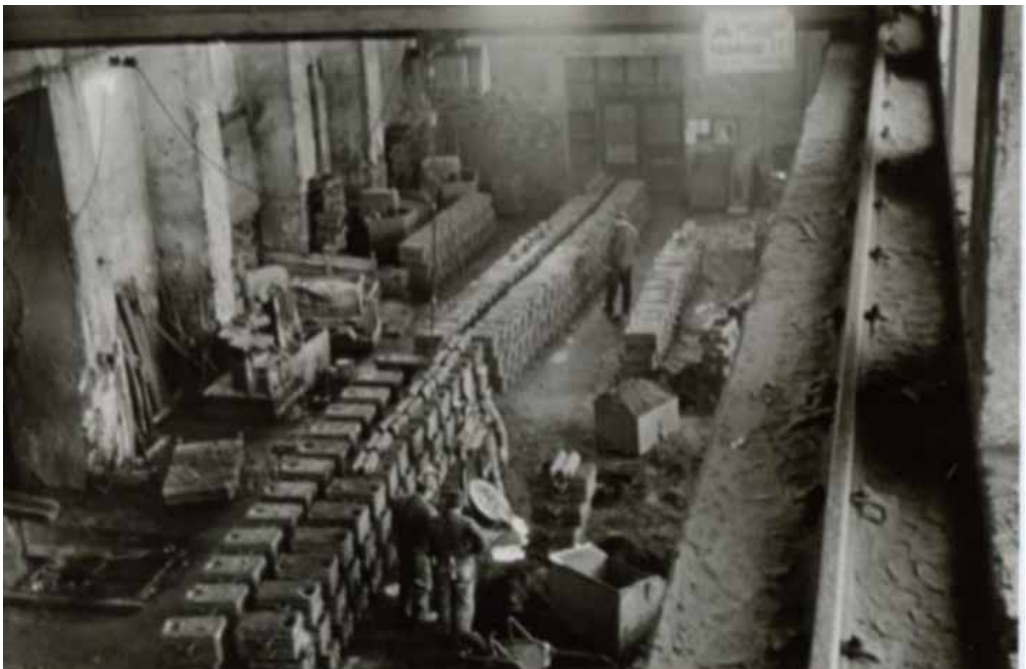
Slika 3. Železniška livarna pred rekonstrukcijo (1978)
